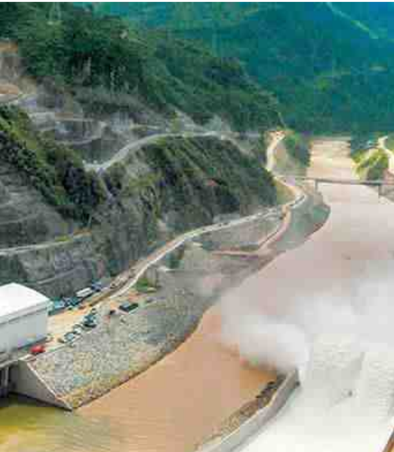
เขื่อนไฟฟ้าพลังน้ำ น้ำจึม 2 สปป.ลาว
